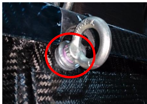
I ボルト修正箇所
